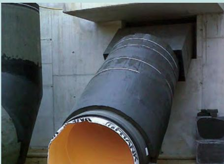
Isoliertes Lüftungsrohr mit Übergang auf rechteckigen Gebäudeanschluss
