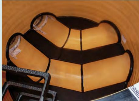
Kontrollschacht mit parallel laufendem abgewinkeltem Gerinne
