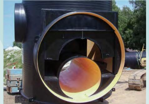
Einlaufbauwerk mit schwimmender Tauchwand
