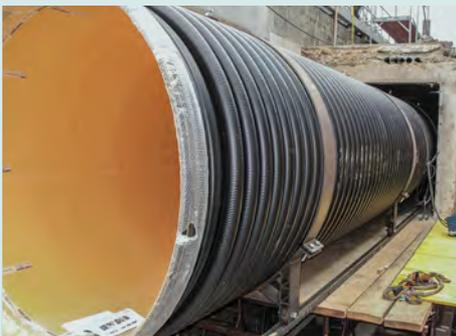
PKS<sup>®</sup>-Inlinerrohr vorbereitet auf Gleitkufen zur schnellen Installation
