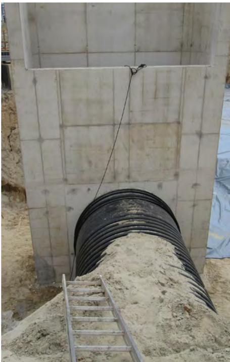
Standardmäßig verwenden wir die Werkstoffe PE und PP. Je nach Anforderung liefern wir PKS<sup>®</sup>-Lüftungsrohre auch aus elektrisch leitfähigen, schwer entflammbaren oder antimikrobiellen Sonderwerkstoffen. Das System kann gesteckt oder geschweißt werden. Geschweißte PKS<sup>®</sup>-
