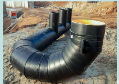
Vorgefertigter Segmentbogen und Verteilerstrang für Lüftung
